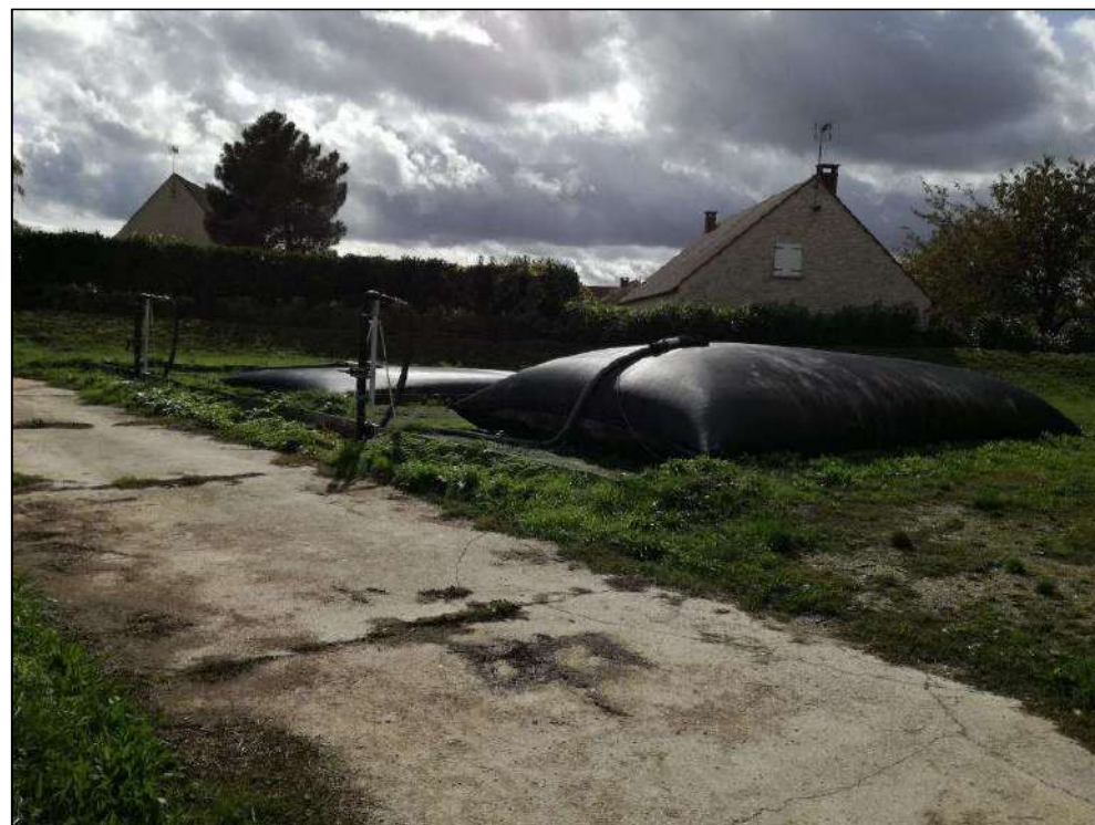
Lits de séchage équipés de bâches filtrantes
