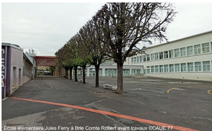
École élémentaire Jules Ferry à Brie Comte Robert avant travaux ©CAUE 77
